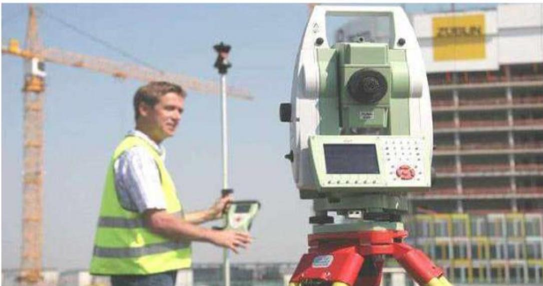
**Gambar 2.31 Pengukuran Jarak Elektronik (EDM)**
