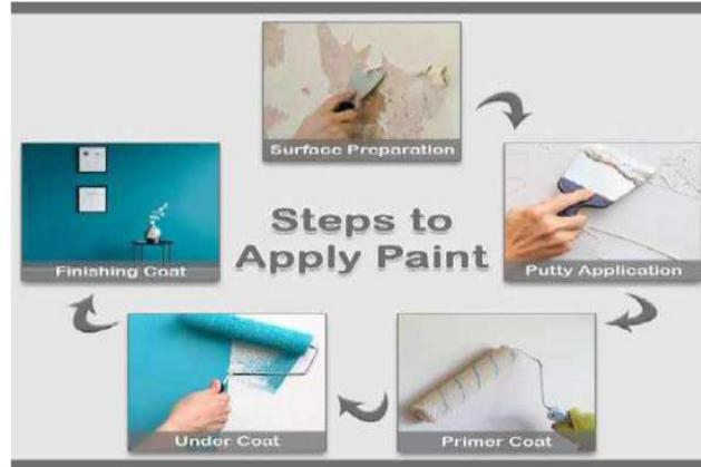
**Gambar 3.60 Langkah Langkah Pengecatan**
